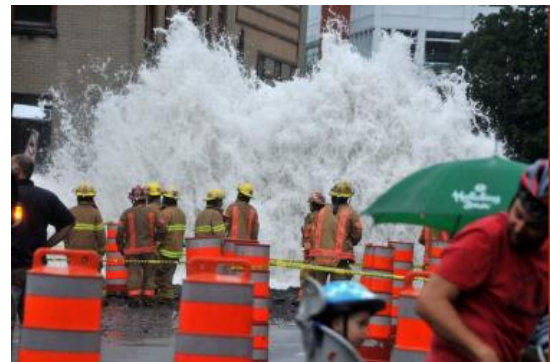
Figure 1: Exemple d'une conduite principale de Montréal sectionnée par un entrepreneur lors d'activités d'excavation
