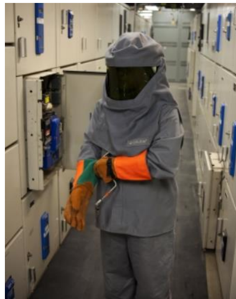
Figure 3: Un travailleur portant de l'équipement de sécurité pour éclairs d'arcs électriques.
