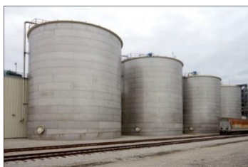
Figure 1 – Réservoirs de stockage de bioéthanol typiques
