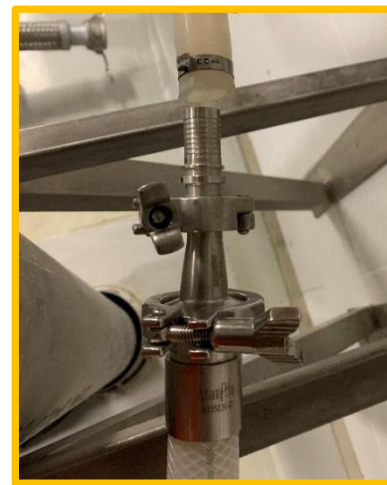
Figure 1 : raccord cannelé avec collier de serrage
