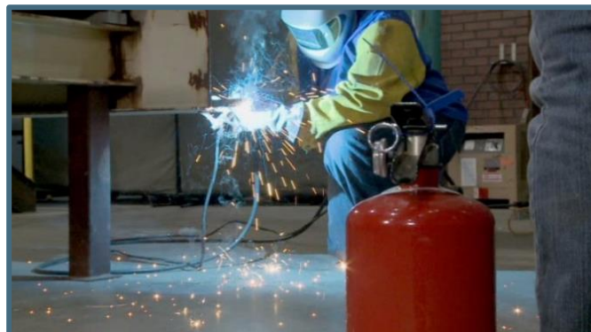
Figure 1 : Prévention des incendies pendant les opérations de travail à chaud
