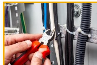
Figure 3 : Image montrant comment couper correctement les attaches en plastique, source iStock.
